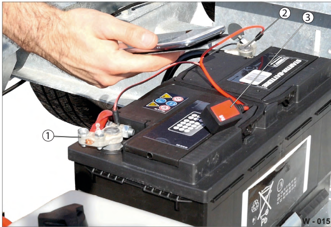
Abb. 28 Versorgungsbatterie laden / prüfen
